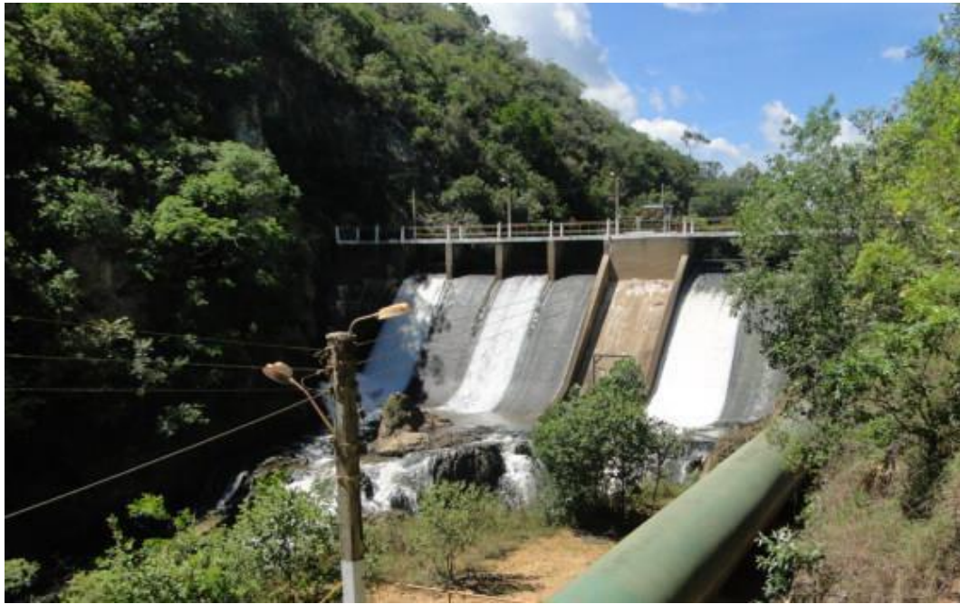
Figura 1 – Vista parcial da CGH Salto da Barra
